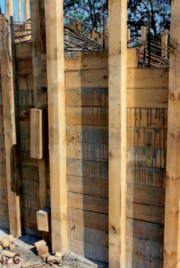
Fot. 5. Wycieki spowodowane nieprawidłowym montażem deskowania
