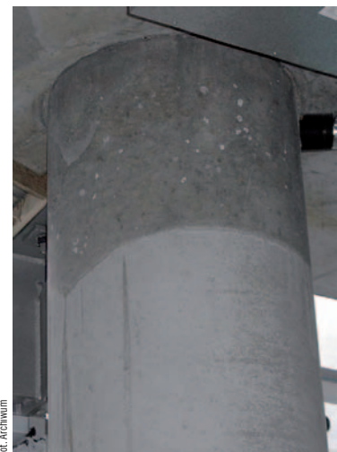
Fot. 14. Zmiany barwy wynikające z różnego czasu rozdeskowania
