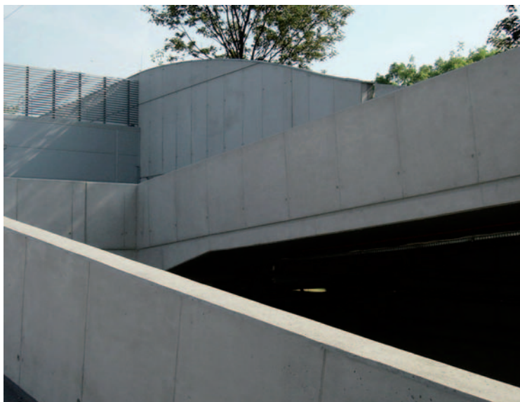
Fot. 9. Planowanie rozmieszczenia deskowania
