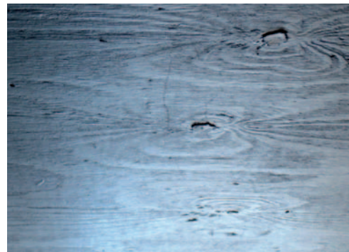
Fot. 3. Odzworowanie tekstury deskowania na powierzchni betonu
