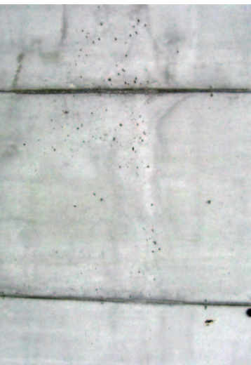
Fot. 11. Nieciągłości struktury w postaci pęcherzy powietrza wynikające z nieprawidłowego zagęszczania
