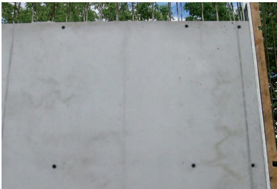
Fot. 10. Efekt nierównomiernego nałożenia środka antyadhezyjnego, tzw. chmurki
