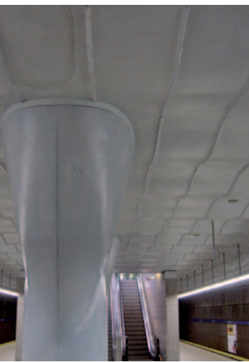
Fot. 1. Beton pokryty kolorową powłoką
