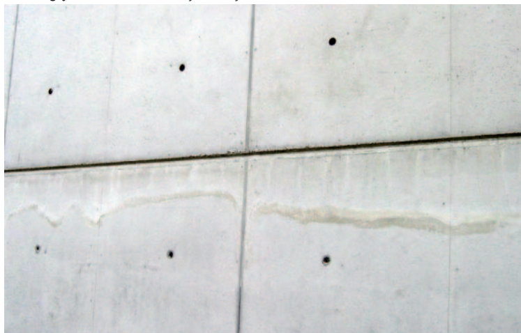
Fot. 8. Tak zwane firanki będące skutkiem wykonywania elementów w poziomych sekcjach i niewzględnienia skurczu dolnej warstwy betonu
