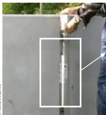
Fot. 1. Dostawianie prefabrykowanych ścian [4]
