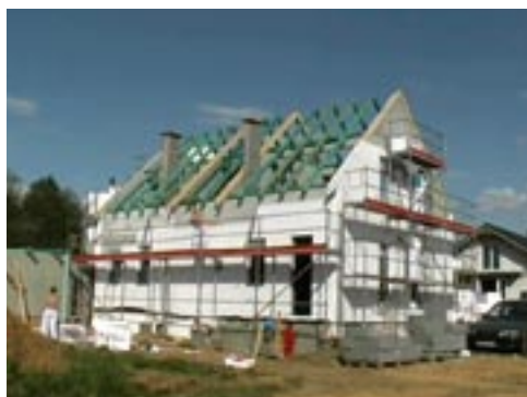
Fot. 6. Termoizolacja domu jednorodzinnego [4]
