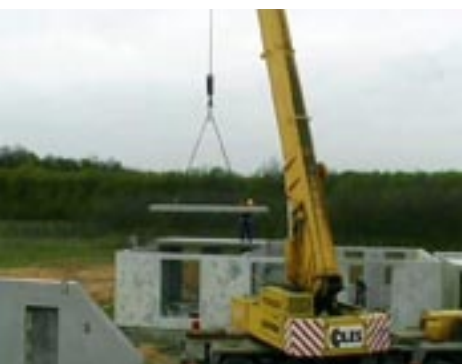
Fot. 5. Montaż prefabrykowanych elementów stropu [4]
