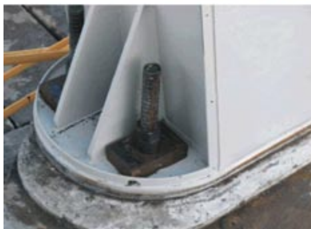
Fot. 1. Montaż stalowych pylonów
