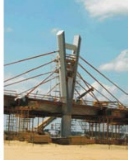
Fot. 2. Montaż want
