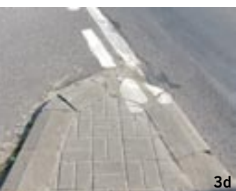
Fot. 3a-d. Przykłady uszkodzeń wynikających z układania łuków „docinanych” i z niestaranności wykonania
