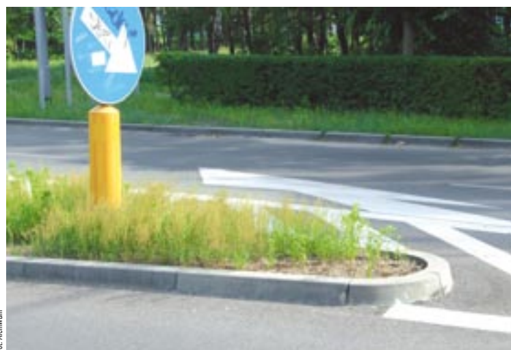
Fot. 2. Przykład zastosowania krawężników łukowych
