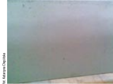
Wpływ procesów technologicznych na jakość powierzchni elementu prefabrykowanego: powierzchnia poprawnie wykonana
