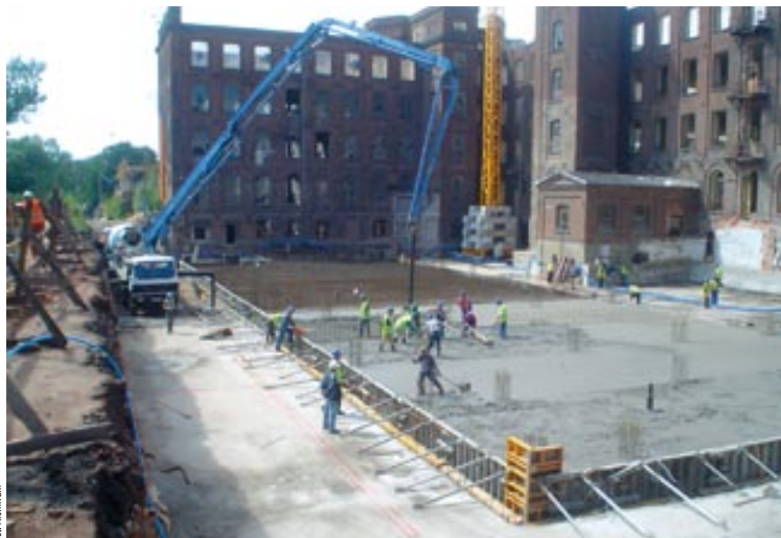
Rysunek 8. Betonowanie płyty fundamentowej
