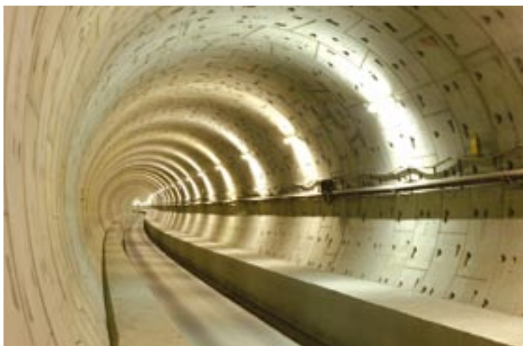
Rysunek 3. Prefabrykaty betonowe z kruszywem węglanowym – kanał La Manche
