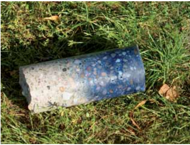
Rys. 3. Widok odwiertu rdzeniowego, na powierzchni którego przeprowadzono pomiar zasięgu karbonatyzacji za pomocą „Rainbow-Testu” ( pH \approx 13 )
