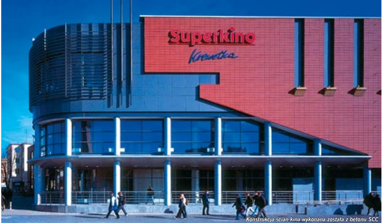
Konstrukcja ścian kina wykonana została z betonu SCC
