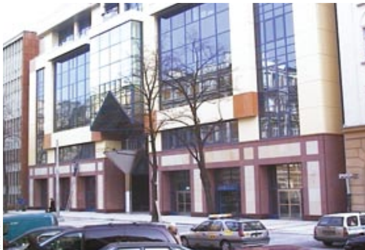
Fot. 9. Elewacja budynków Roma Center w Warszawie
