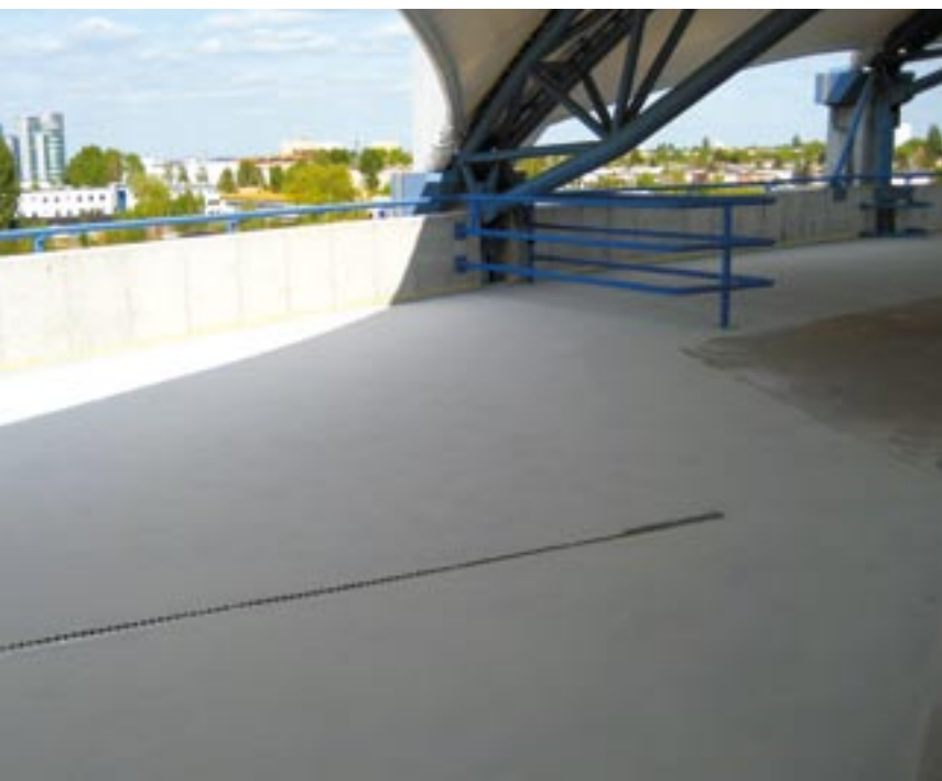
Fot. 12. Płaszczyzny komunikacyjne stadionu zabezpieczone powłokami żywicznymi Sikafloor
