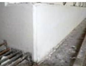
Fot. 3. Prefabrykat bezpośrednio po rozformowaniu
