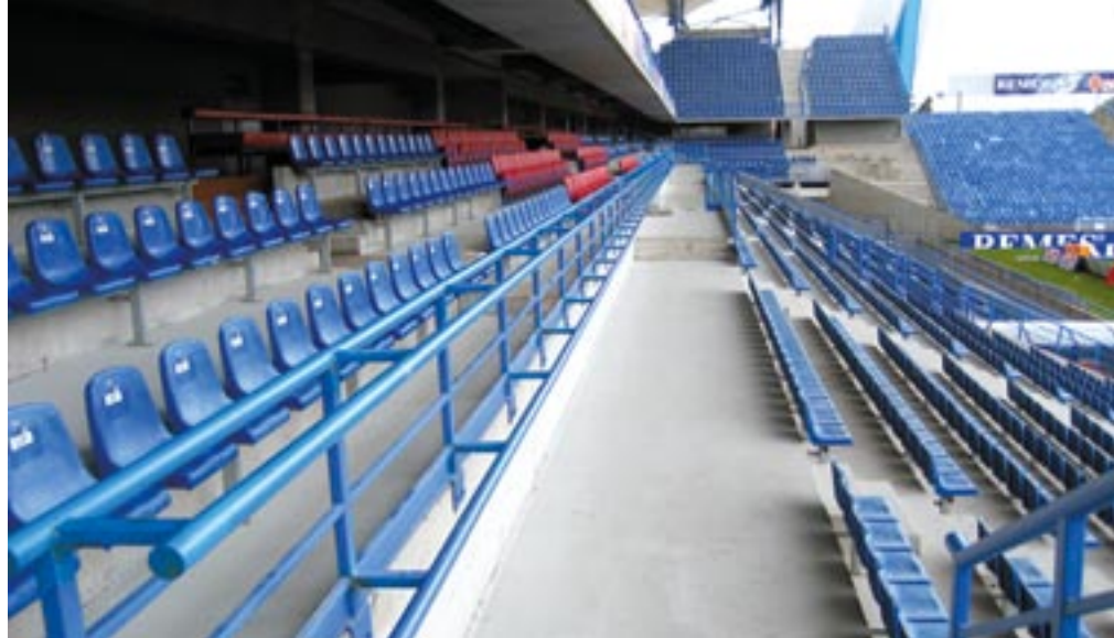
Fot. 1. Gotowe widownie stadionu zabezpieczone powłokami żywicznymi Sikafloor
