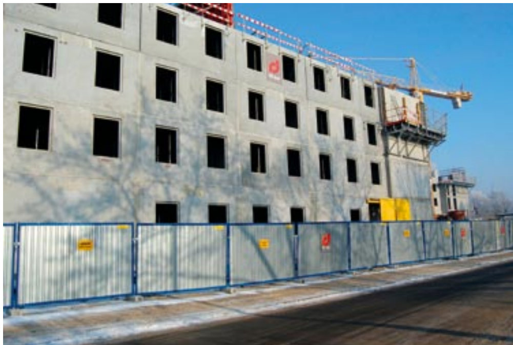
Fot. 5. Realizacja hotelu w Toruniu z elementów prefabrykowanych wykonanych w technologii SDC
