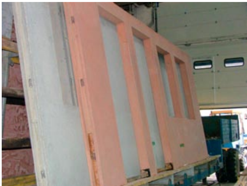
Fot. 6. Zdjęcie gotowych elementów ściennych
