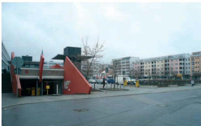
Fot. 1. Frankfurt nad Odrą, widok na Brunnenplatz, zjazd do parkingu podziemnego
