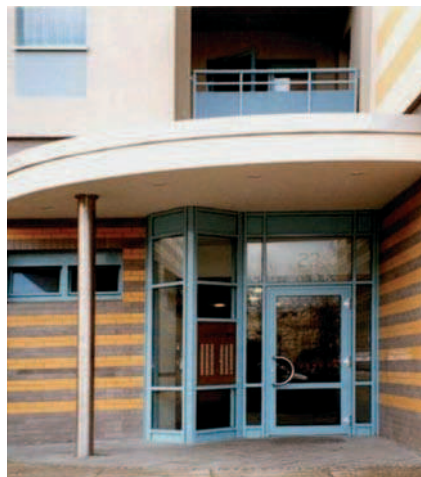
Fot. 10. Poczdam: Breite Straße 23, stan po przebudowie wejścia do budynku
