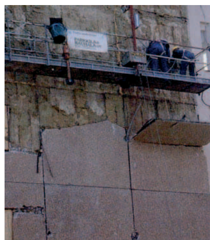
Fot. 15. Widok elewacji w trakcie demontażu warstwy fakturowej w budynku wielkopłytywym
