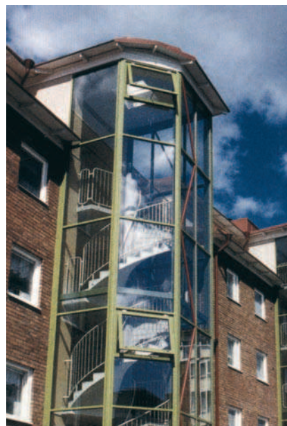
Fot. 14. Widok budynku po wstawieniu windy w miejscu biegu schodowego i dostawieniu klatki schodowej
