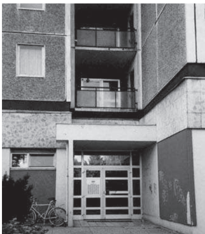
Fot. 9. Poczdam: Breite Straße 23, stan przed przebudową wejścia do budynku
