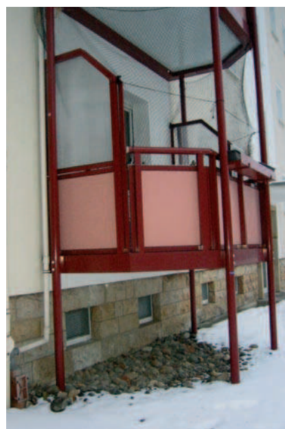
Fot. 6. Drezno, budynek po dostawieniu balkonów
