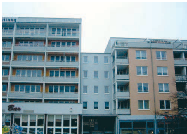
Fot. 4. Frankfurt nad Odrą, budynek przy Brunnenplatz po przebudowie. Wprowadzono tarasy na ostatniej kondygnacji i usługi na parterze
