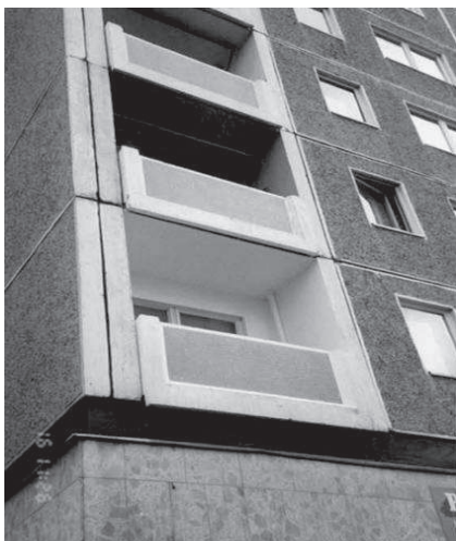
Fot. 7. Poczdam: Breite Straße 23, stan przed zabudową loggi, wg indywidualnego projektu
