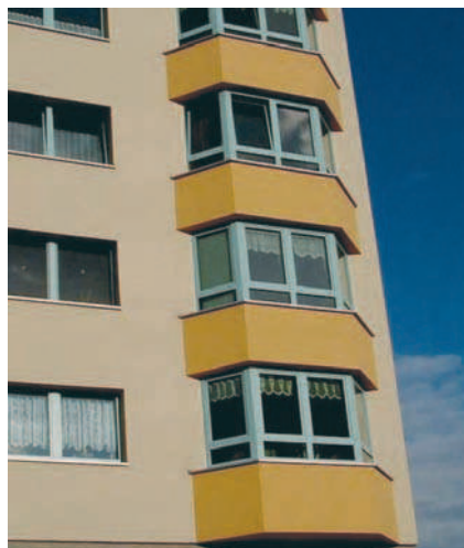
Fot. 8. Poczdam: Breite Straße 23, stan po zabudowie loggi
