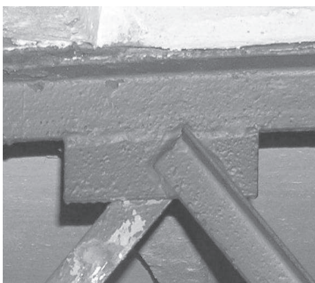
Rys. 7. Węzeł pośredni pasa górnego
