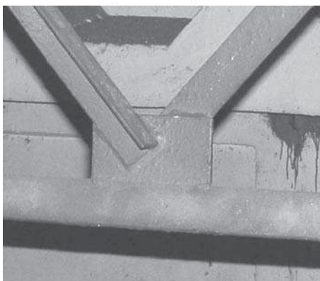
Rys. 6. Węzeł pośredni pasa dolnego
