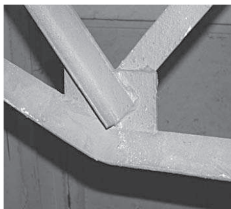
Rys. 8. Węzeł skrajny pasa dolnego
