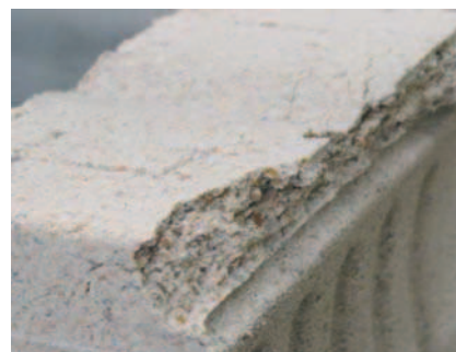
Rys. 8. Łuszczenie się krawędzi w bloku [4]
