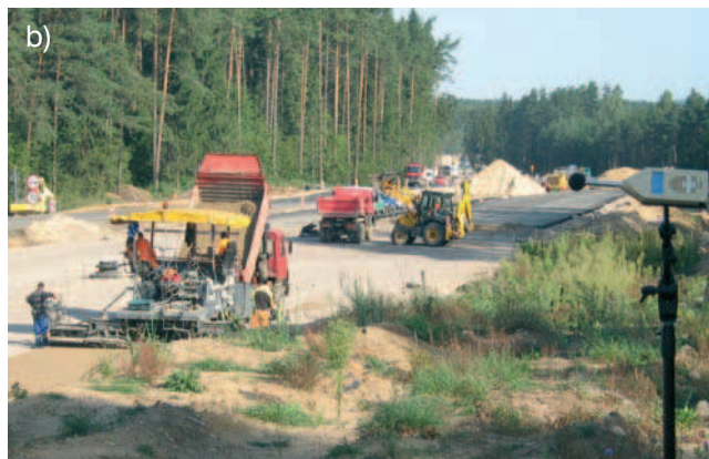
Rys. 1. Roboty przy budowie odcinka drogi krajowej nr 8 (Białystok – Katryńka): a) profilowanie podłoża gruntowego, b) wykonywanie dolnej warstwy podbudowy z kruszywa łamanego
