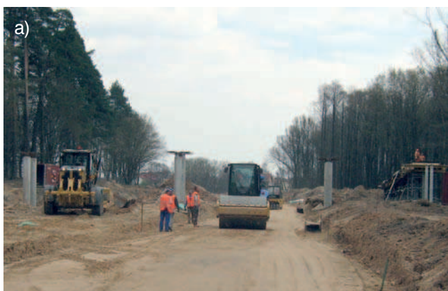
Rys. 3. Pomiary hałasu przy wykonywaniu warstwy mrozoochronnej (budowa odcinka ul. Zwierzynieckiej w Białymstoku): a) widok robót, b) pomiar w odległości 25 m od granicy robót
