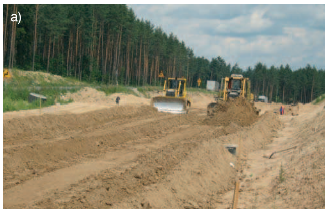
Rys. 1. Roboty przy budowie odcinka drogi krajowej nr 8 (Białystok – Katryńka): a) profilowanie podłoża gruntowego, b) wykonywanie dolnej warstwy podbudowy z kruszywa łamanego
