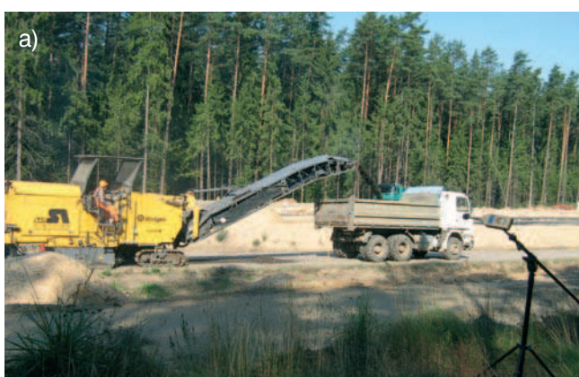
Rys. 2. Pomiary hałasu przy frezowaniu zniszczonej nawierzchni (odcinek dk nr 8: Białystok – Katryńka): a) pomiar w odległości 25 m od miejsca robót, b) pomiar w odległości 50 m od miejsca robót
