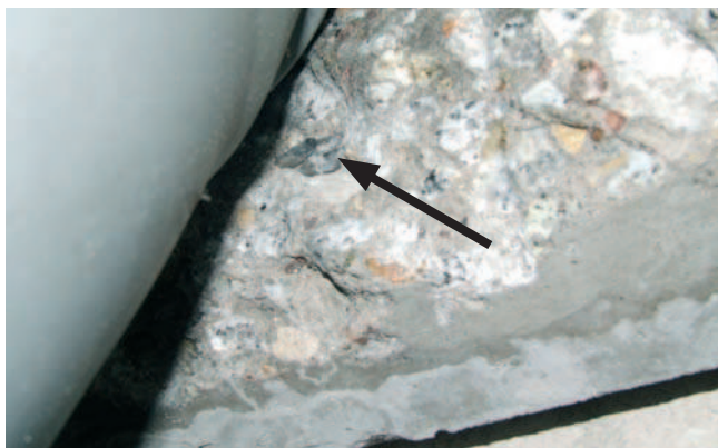
Rys. 14. Rozkucie żeberka z odsłonięciem splotu i przecięciem dwóch drutów w splocie (strzałka)
