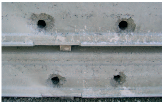
Rys. 5. Otwory przebite na całej szerokości płyty w celu umieszczenia poprzeczek montażowych
