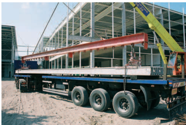
Rys. 1. Prawidłowy chwyt elementu oraz oparcie na środku transportowym
