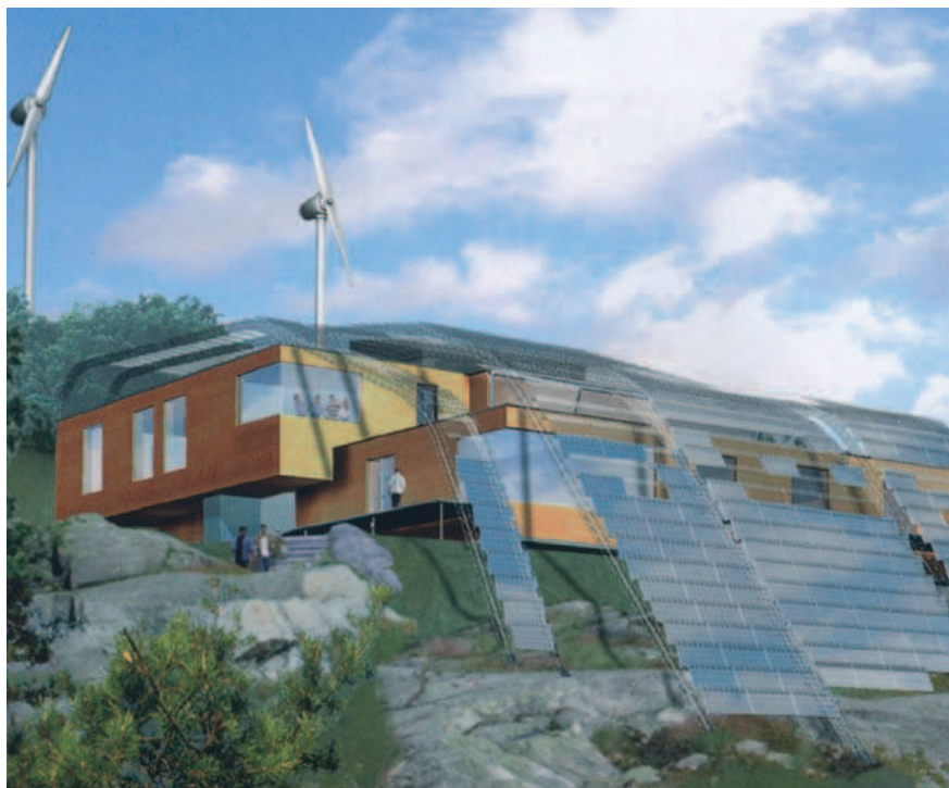
Budynek o zerowym zapotrzebowaniu energii według projektu firmy NCC
