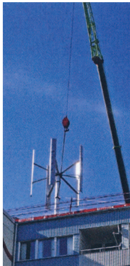
Montaż agregatu wiatrowego na dachu budynku mieszkalnego w Gärdsås Göteborg
