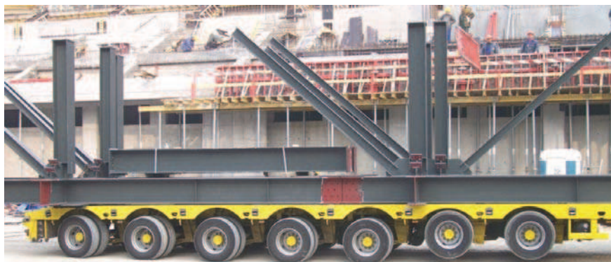
Rys. 6. Transport elementów wysyłkowych kratownic podłużnych rusztu dachowego
