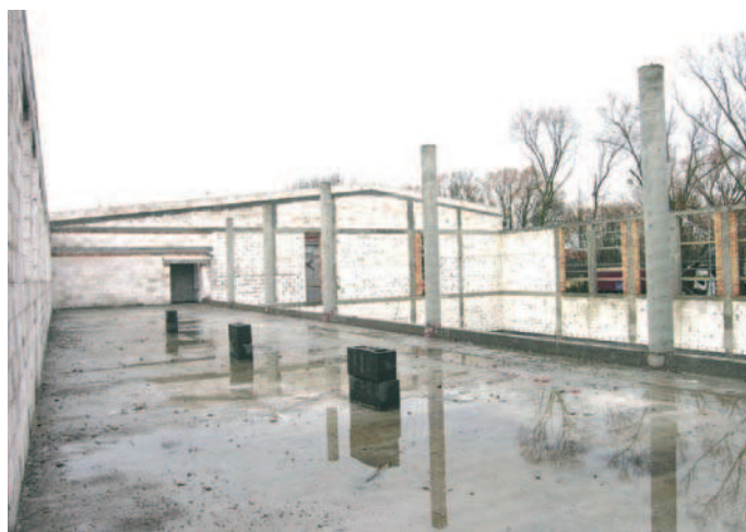
Rys. 1. Widok z poziomu stropu na I piętrze na słupy przewidziane jako podpora pośrednia dla stalowych kratownic układu nośnego dachu
