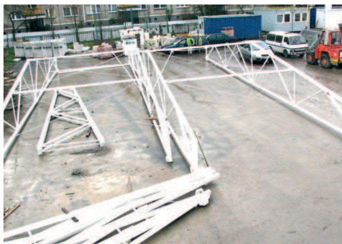
Rys. 2. Bloki montażowe układu nośnego dachu przewidziane do ustawienia nad częścią główną hali
