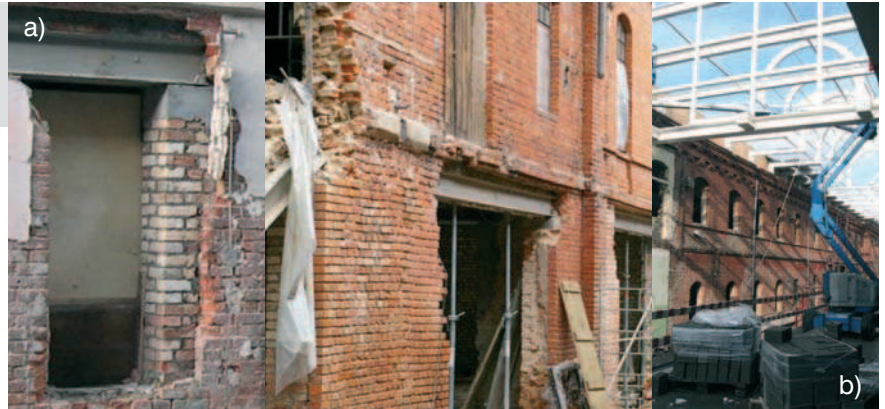
Rys. 2. a) Widok nadproży witryny, b) widok konstrukcji stalowej nad pasażem, wspartej na ścianie zewnętrznej (1)
