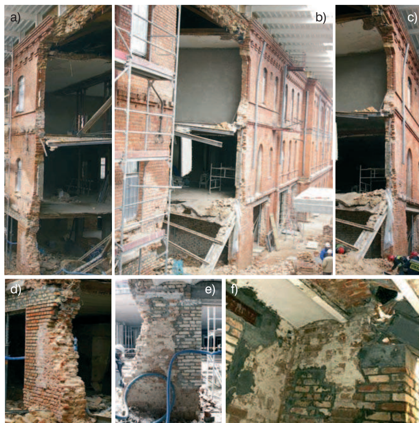
Rys. 4. a), b), c) Widok zniszczenia ściany zewnętrznej w osi (1) na długości około 11 m i stropów nad parterem, I i II p., d) zniszczenie części filara (20) w kondygnacji parteru, e) widok stropu odcinkowego nad parterem w strefie zniszczonego filara (20), f) zniszczenie na podporze filara (18)
