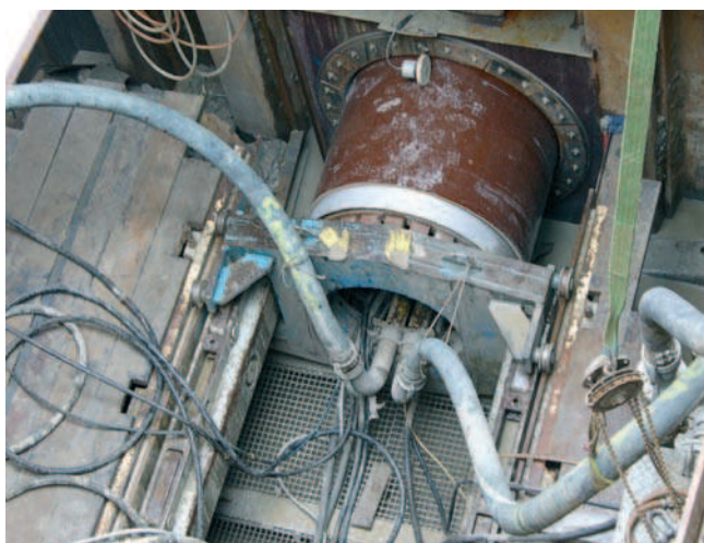
Rys. 11. Uszczelnienie okna wejściowego wokół przeciskanej rury kamionkowej (zdjęcie własne)
