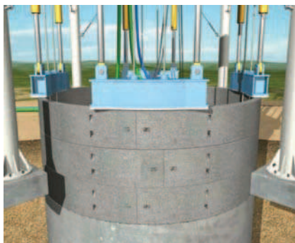
Rys. 18. Wciskanie w grunt elementów obudowy komory za pomocą siłowników hydraulicznych umieszczonych w ramie przeciskowej [1]
