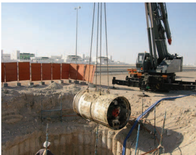
Rys. 9. Obudowa wykopu początkowego z pali wierzonych [2]
