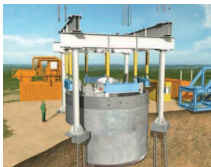
Rys. 14. Konstrukcja wsporcza ramy przeciskowej [1]
