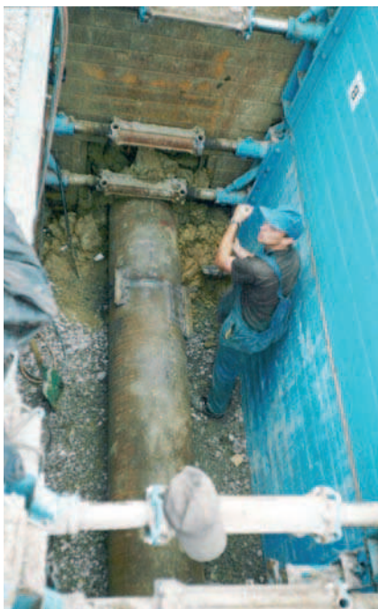
Rys. 6. Wykop początkowy o ścianach zabezpieczonych płytami wykopowymi (zdjęcie własne)
