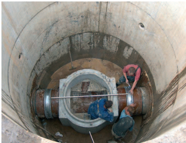
Rys. 10. Wbudowanie studni rewizyjnej na dnie obudowanego wykopu docelowego (zdjęcie własne)
