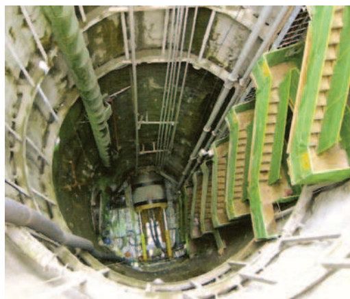
Rys. 1. Wykop początkowy o głębokości 45 metrów, 20 m poniżej poziomu zwierciadła wody gruntowej, wykonany w Korei dla wbudowania mikrotunelu [1]
