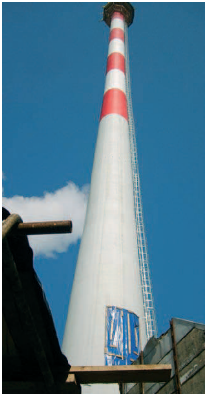
Rys. 2. Koniec robót ślizgowych
