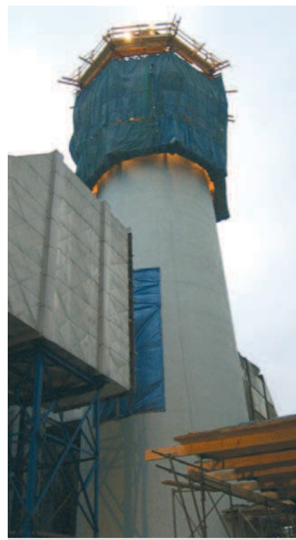
Rys. 1. Początek robót ślizgowych, luty 2008 r.
