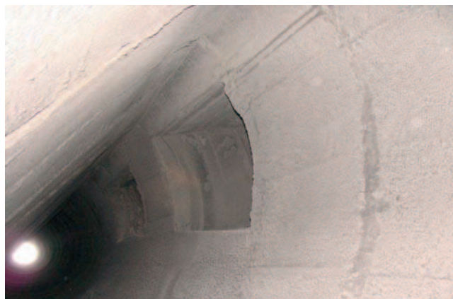
Rys. 4. Wzmocnienie uszkodzonego przewodu żarobetonowego w strefie otworów wlotowych za pomocą powłoki z betonu żaroodpornego
