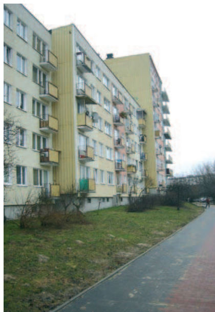
Rys. 19. Budynek wielkopłytowy przy ul. Kiepury 13, narożnik północno-zachodni, stan marzec 2006 r.
