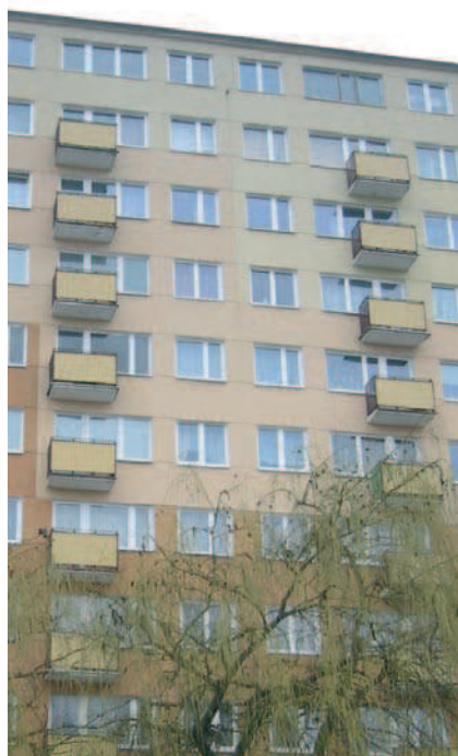
Rys. 21. Budynek wielkopłytowy przy ul. Kiepury 13, narożnik południowo-zachodni, stan marzec 2006 r.
