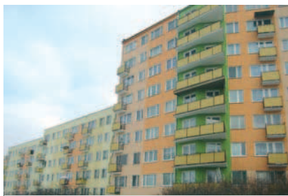
Rys. 8. System wielkopłyty, II ETAP – belko-ściany na fasadach i wymiana ocieplenia na filarkach międzyokienne – BSO (styropian). Ściany szczytowe bez zmian, stan w 2002 r. [11]
