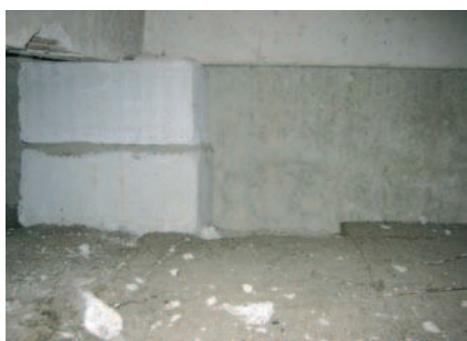
Rys. 11. Pierwotne ocieplenie stropodachu wełną mineralną [11]
