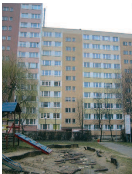
Rys. 1. Budynek systemu wielkopłytowego przy ul. Kiepury 11–13, elewacja wschodnia po drugim etapie ocieplenia, stan 2006 r.
