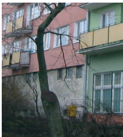
Rys. 23. Budynek wielkopłytowy przy ul. Kiepury 13, narożnik południowo-zachodni, stan marzec 2006 r.
