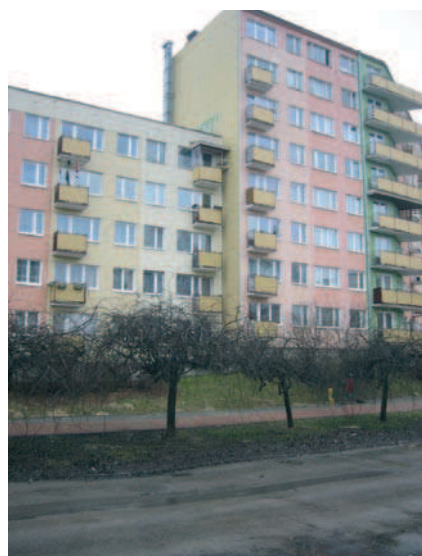
Rys. 2. Budynek systemu wielkopłytowego przy ul. Kiepury 15–13, elewacja zachodnia po drugim etapie ocieplenia, stan 2006 r.
