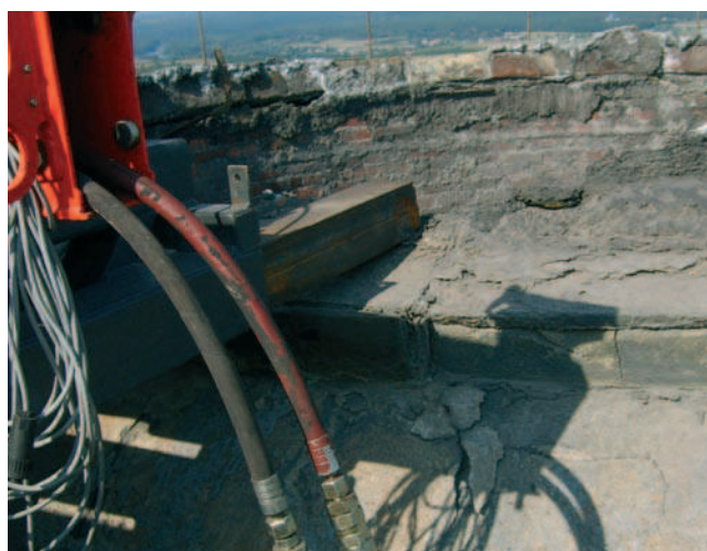
Fot. 2a. Rozpoczęcie robót rozbiórkowych
