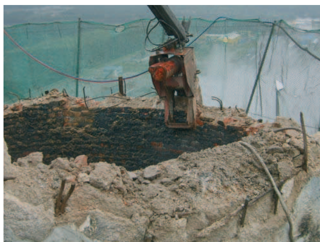
Fot. 2b. Etap I – kruszenie komina hydrauliczną szczęką z wrzucaniem urobku do drąży
