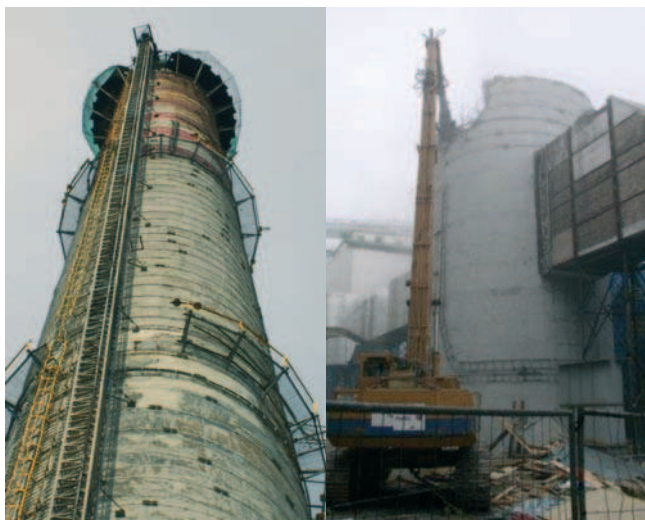
Fot. 3. Początkowa faza rozbiórki komina
