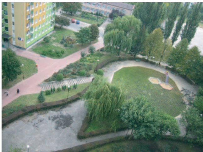
Rys. 4. Widok placu zabaw z lotu ptaka, nawierzchnię należy wymienić [13]
