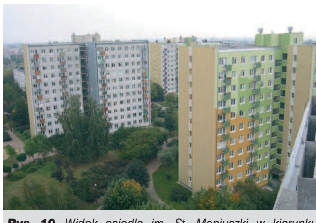
Rys. 10. Widok osiedla im. St. Moniuszki w kierunku zachodnim. Zabudowa wieloblokowa. Na lewo budynek przed, na prawo – po III etapie ocieplenia [13]
