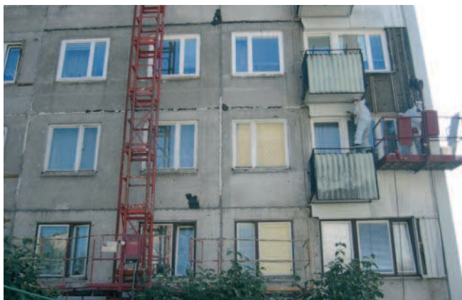
Rys. 7. Ściana zewnętrzna osłona w trakcie demontażu ocieplenia II etapu. Pracownicy w specjalnym ubraniu ochronnym demontują okładzinę z płyt azbestowych [13]
