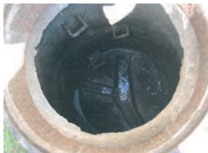
Rys. 17. Studzienka rewizyjna kanalizacji [13]
