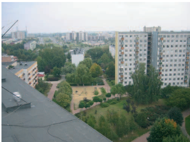
Rys. 3. Widok budynku systemu wieloblokowego po II etapie ocieplenia (2004) [13]
