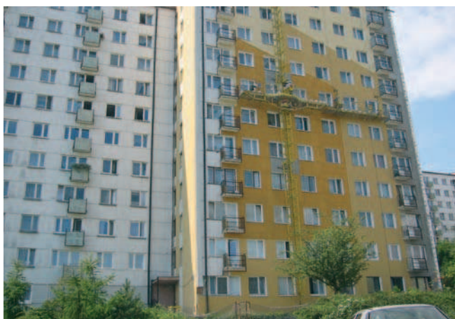
Rys. 9. Realizacja termicznej modernizacji ścian III etapu – budynek przy ul. Kiepury 9, sierpień 2003 [13]
