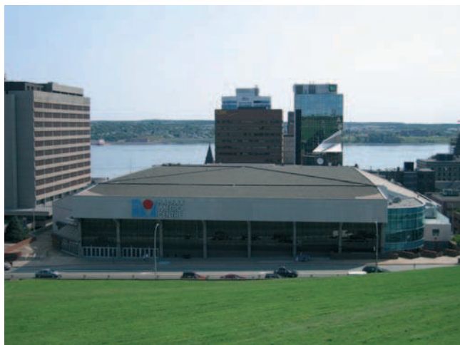
Rys. 23. Widok hali Metro Halifax Centre (dzięki uprzejmości SMARTEC SA, Manno, Szwajcaria)
