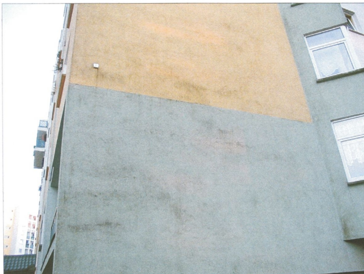
Rys. 5. Elewacja budynku przy ul. Aluzyjnej 33 Photo 5. The facade of house on Aluzyjna street
