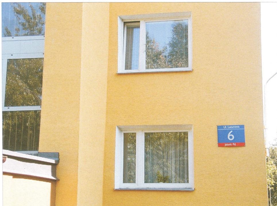
Rys. 4. Elewacja budynku przy ul. Lazurowej Photo 4. The facade of house on Lazurowa street
