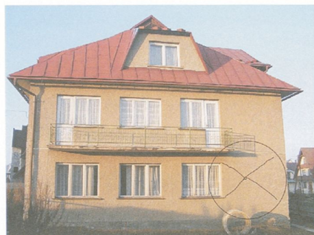
Rys. 4. Skutki wstrząsu sejsmicznego na Podhalu w 2004 r.: a) Ciche-Miętustwo, dom parafialny, widok ogólny, b) tzw. krzyż św. Andrzeja (widok od wewnątrz)
