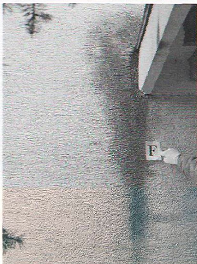
Stan powierzchni przed potraktowaniem jej środkiem glonobójczym
