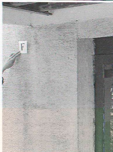
Stan powierzchni po miesiącu od chwili potraktowania jej środkiem glonobójczym
