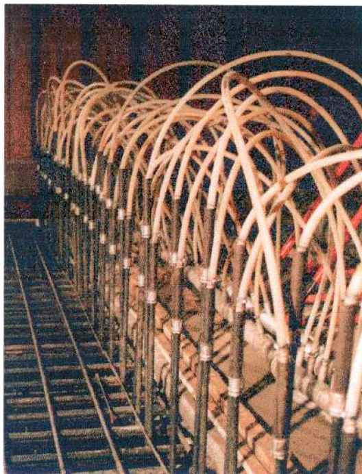
Rys. 10. Rozmieszczenie instalacji chłodzącej wewnątrz jednej sekcji bloku B2 Fig. 10. Distribution of cooling installation inside one section of block B2
