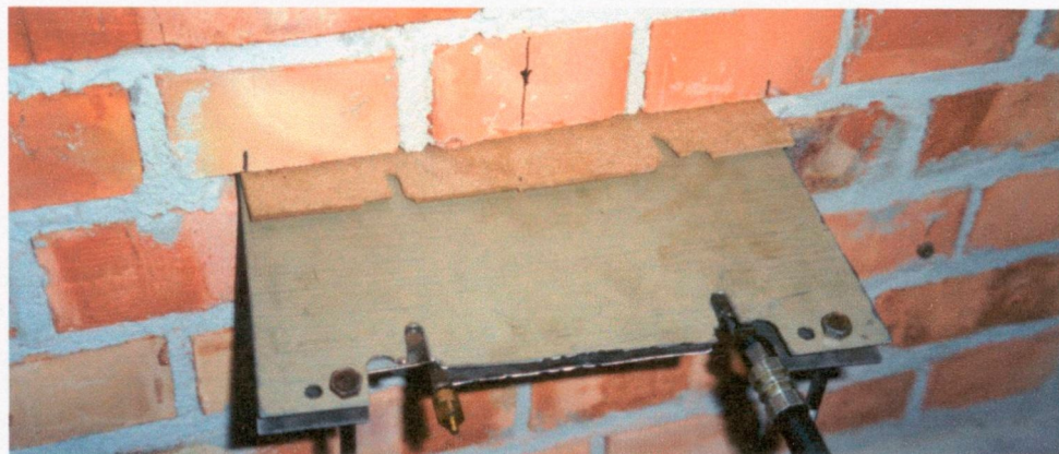
Rys. 6. Przekładki dystansowe chroniące poduszkę ciśnieniową Fig. 6. Flatjack covered with shims
