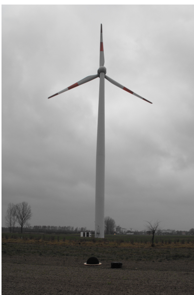
Rys. 5. Widok punktów pomiarowych sygnałów niskoczęstotliwościowych – Turbina 2
