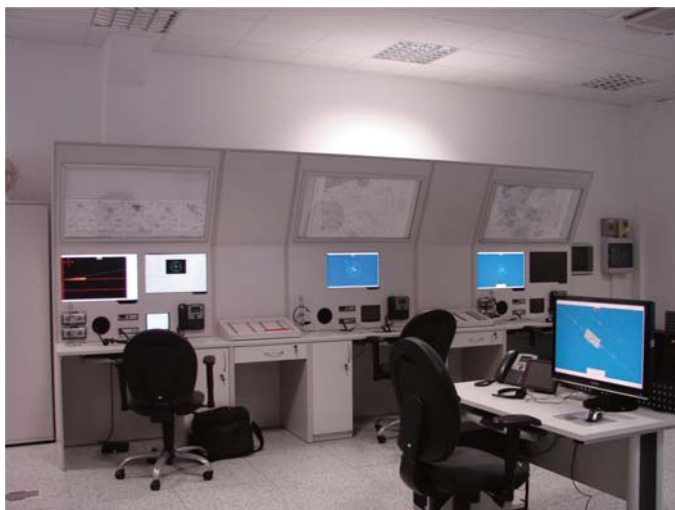
Fot. 5. Stanowiska radarowe: PAR (z lewej) i APP (z prawej), w środku stanowisko asystenta APP (fot. T. Compa)
