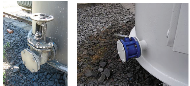
Fot. 2. Wymiana niesprawnego zaworu spustowego na nowy kulowy
