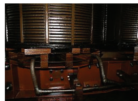
Fot. 10. Wysłunięcie klocków izolacji wyrównawczej dolnej części wszystkich uzwojeń,
