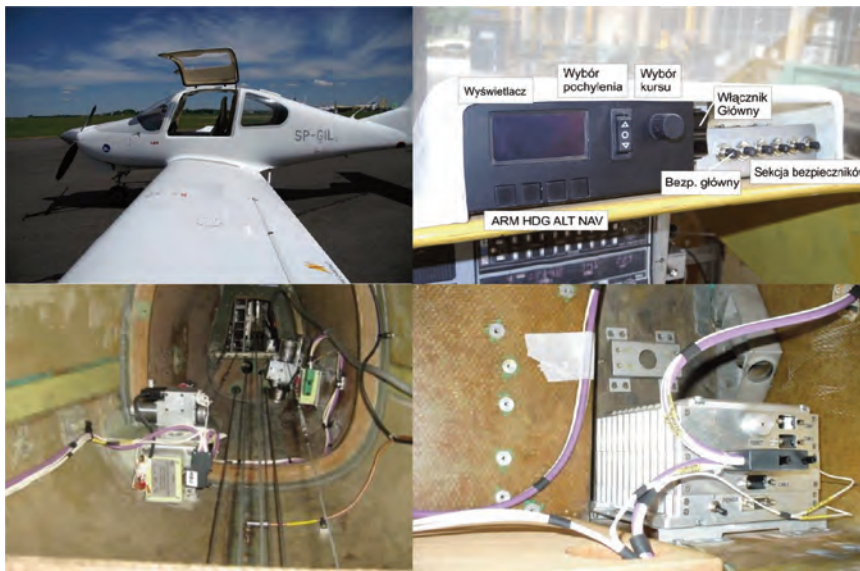
Rys. 2. Zabudowa systemu FRF i doświadczalnego systemu sterownia na samolocie I23 Manager
