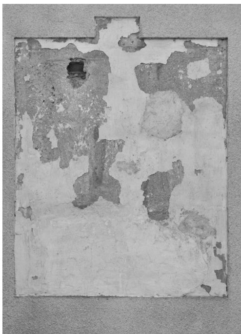
Rys. 1. Stan obiektu przed konserwacją w 2008 r. Fig. 1. State of the object before restoration in 2008
