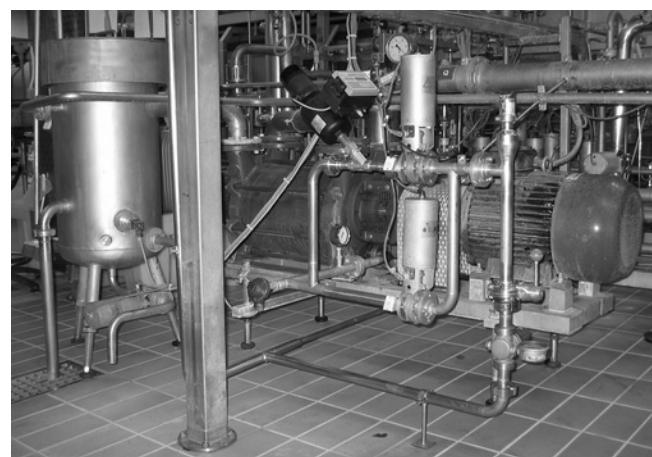
Rys. 1. Pompa próżniowa zintegrowana z monoblokiem
