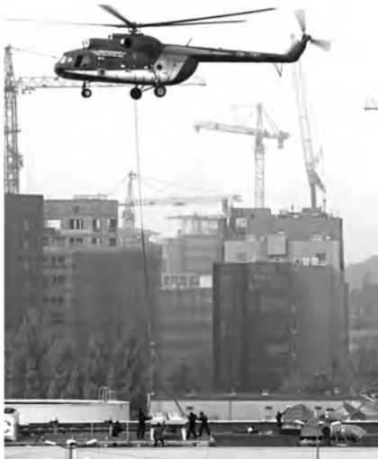
Rys. 7. Operacje dźwigowe w aglomeracji miejskiej (foto K. Tracz)
