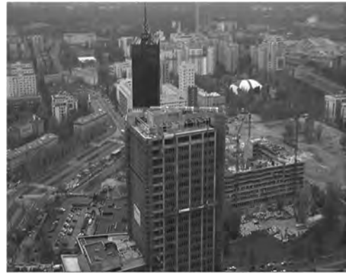
Rys. 4. Zabudowa dachu praktycznie uniemożliwiająca przeprowadzenie akcji ratowniczej [6]
