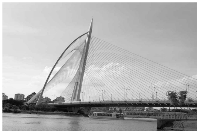
Fig. 1. Suspended bridge Rys. 1. Most podwieszony
