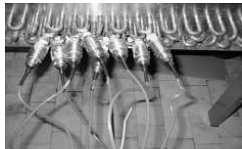
Rys. 8. Widok czujników pomiarowych zainstalowanych w przekrojach węzownicy rurowej Fig. 8. View of measuring sensors installed in the coil tube cross-sections
