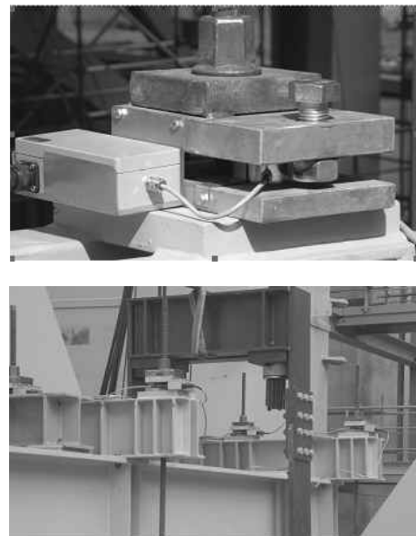
Rys. 3. Widok głowic pomiarowych zamontowanych na cięgnach Fig. 3. Placement of measurement units on strings
