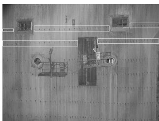
Rys. 2. Zdjęcie podczas remontu parownika kotła z zaznaczonymi poziomami, dla których wykonano pomiary
