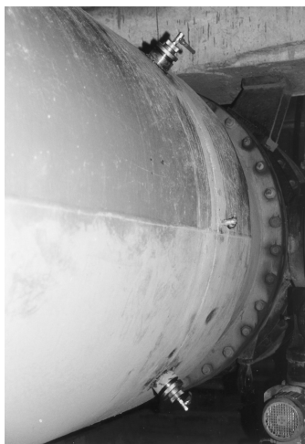
Rys. 2. Sposób zamocowania sond uśredniających w rurociągu Fig. 2. Attachment method of averaging probes in pipeline
