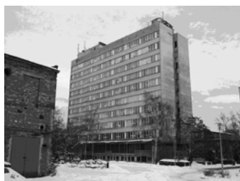
Rys. 8. Budynek biurowy, w którym wykonywane były pomiary zasięgu modemów PLC Fig. 8. The office building used for measurements of PLC transmission range
