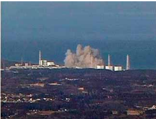
Rys. 4. Pożar Elektrowni Jądrowej Fukushima [9] Fig. 4. A fire of Fukushima Nuclear Power Plant [9]
