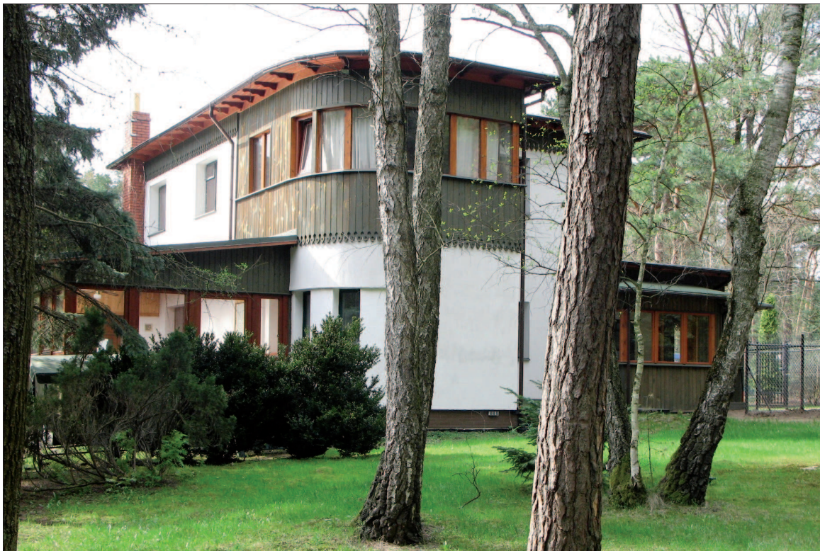
22. Widok budynku przy ul. Lipowej 2. Fot. A. Dymek, 2012 22. View of the Lipowa 2 building. Photo A. Dymek 2012
