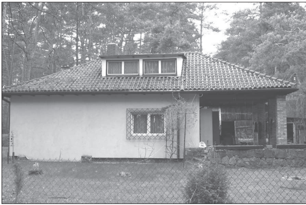
19. Elewacja boczna budynku przy ul. Redutowej 39.
