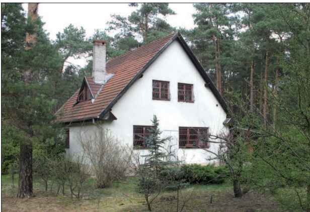
25. Widok budynku przy ul. Bernardyńskiej 17. Fot. A. Dymek, 2012
