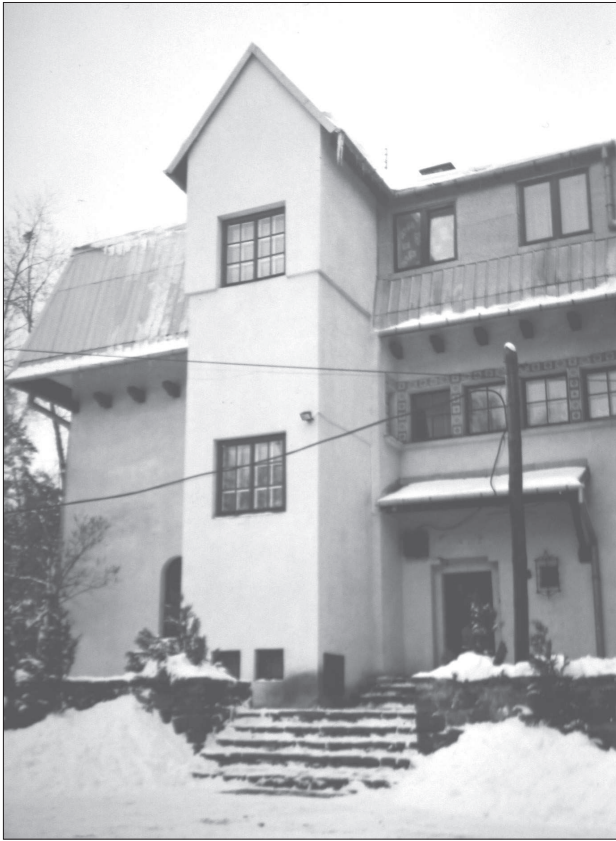
7. Fragment elewacji tylnej budynku przy ul. Myśliwskiej 2 – nieistniejące okiennice. Fot. z: Kronika Domu Dziecka nr 14 w Otwocku , 2002
