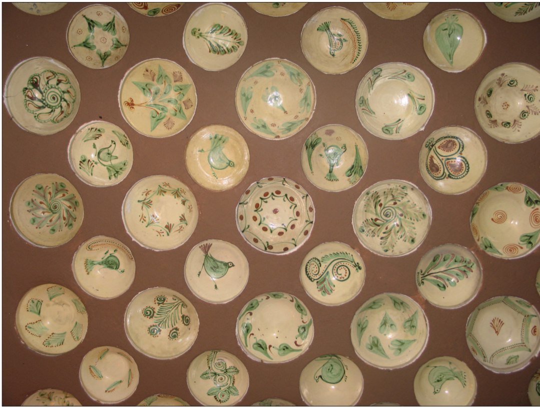
11. Fragment stropu zdobionego glinianymi misami w d. domu własnym arch. L. Korngolda w Warszawie przy ul. Królowej Aldony 3. Fot. A. Dymek, 2012
