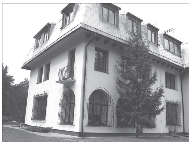
10. Widok budynku przy ul. Myśliwskiej 2 od strony południowo-wschodniej. Fot. A. Dymek, 2012 10. South-east view of the Myśliwska 2 building. Photo A. Dymek 2012
