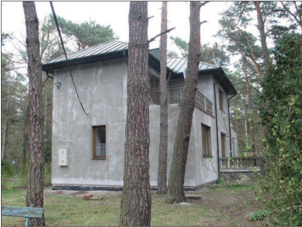
24. Widok budynku przy ul. Litewskiej 20. Fot. A. Dymek, 2012
