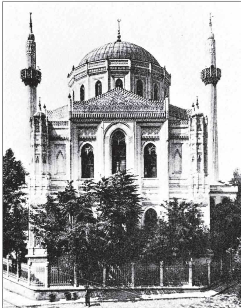
12. Meczet Pertevniyal Valide Camii, 1871 12. The Pertevniyal Valide Camii, 1871
