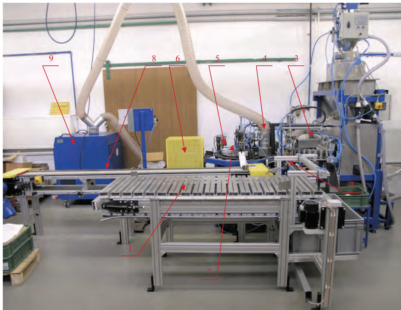
Fot. 2. Rozmieszczenie części składowych linii montażowej w hali produkcyjnej ETI-POLAM: 1 – transporter wejściowy (bufor), 2 – transporter pośredni, 3 – stół zasypowy, 4 – manipulator przekładający wkładki pomiędzy stołami, 5 – stół montażowy wkładek, 6 – tamponiarka, 7 – manipulator przekładający wkładki na transporter wyjściowy, 8 – transporter wyjściowy, 9 – urządzenie odpylające
