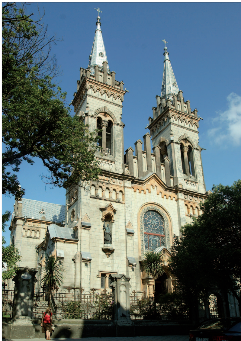
17. Batumi, dawny kościół rzymskokatolicki, obecnie cerkiew p.w. Najświętszej Marii Panny, 1898-1903. Proj. Aleksander S. Rogojski. Fot. Autor, 2011 r.
