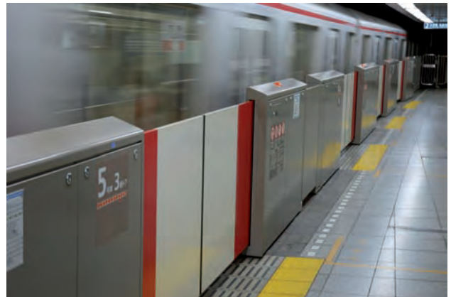
Rys. 2. Przesuwne półściany w metrze w Tokio
